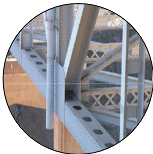
Антикоррозийная обработка металлоконструкций
